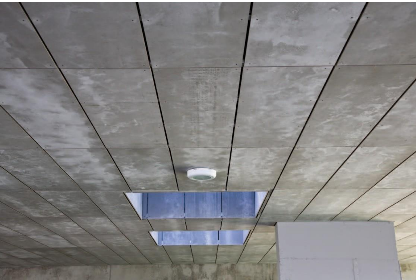
Hall Viroci ripplagi | Escola Barrio de la Paz | Estructuras Aragón | Zaragoza, Hispaania
